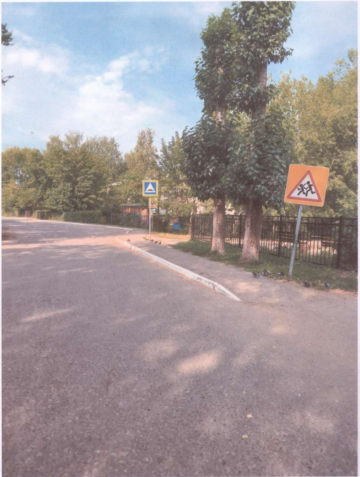
УЧАСТОК ДОРОГИ УЛ. ШКОЛЬНАЯ, ВИД СО СТОРОНЫ ДОМА ~ 10
