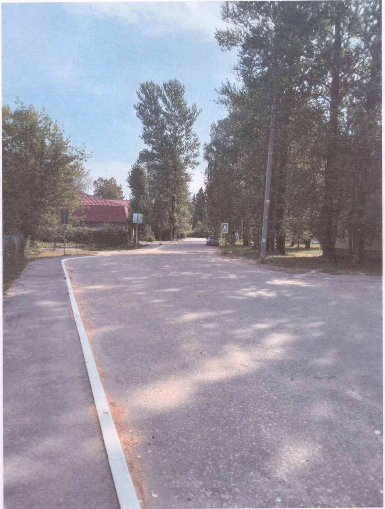
УЧАСТОК ДОРОГИ УЛ. ШКОЛЬНАЯ, ВИД СО СТОРОНЫ ДОМА № 9
